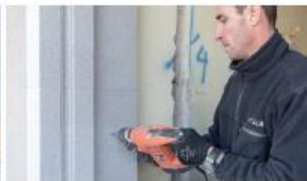
9 ESEGUIRE LA FORATURA NEL MURO
