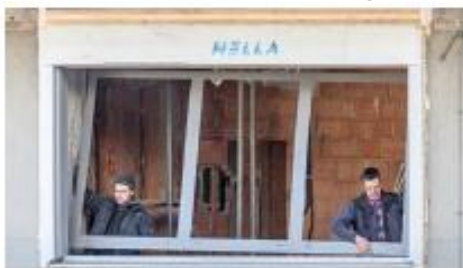
13 INSERIRE IL TELAIO FINESTRA
