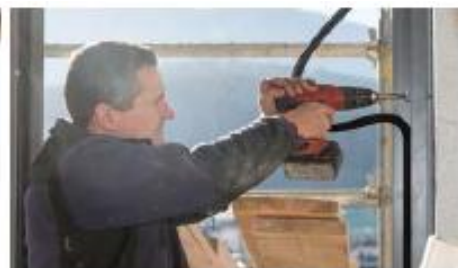
15 AVVITARE IL TELAIO FINESTRA
