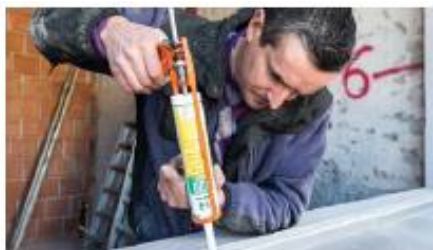
11 MONTARE IL DAVANZALE FINESTRA ESTERNO
