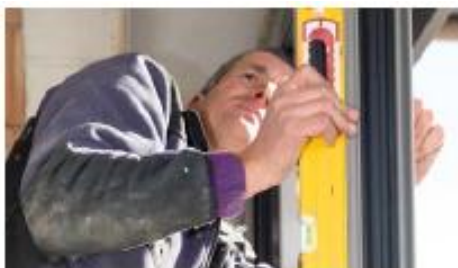
14 CONTROLLARE ANCORA L'ALLINEAMENTO DELLA FINESTRA
